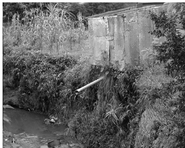
Photo 2. Dispositifs d'évacuation des matières fécales dans les quartiers d'habitat spontané de Yaoundé. À gauche, un simple trou réalisé dans le sol sans protection aucune ; à droite, urines et matières fécales sont rejetées dans la rivière à l'aide d'un tuyau de PVC de 10 cm de diamètre. La fosse en elle-même est une petite excavation étanche, dallée, de 10 à 15 cm de diamètre. (Clichés Nguendo Yongsy, 2004.)
