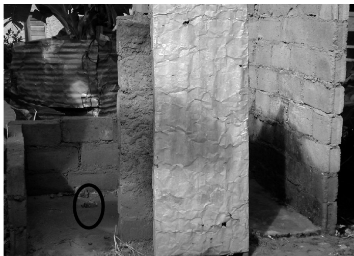
Photo 2. Dispositifs d'évacuation des matières fécales dans les quartiers d'habitat spontané de Yaoundé. À gauche, un simple trou réalisé dans le sol sans protection aucune ; à droite, urines et matières fécales sont rejetées dans la rivière à l'aide d'un tuyau de PVC de 10 cm de diamètre. La fosse en elle-même est une petite excavation étanche, dallée, de 10 à 15 cm de diamètre. (Clichés Nguendo Yongsy, 2004.)
